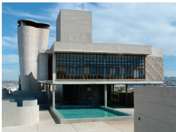
Ilustración 3. Le Corbusier. Unité d'Habitation, Marsella (1947-1952). Cubierta.
